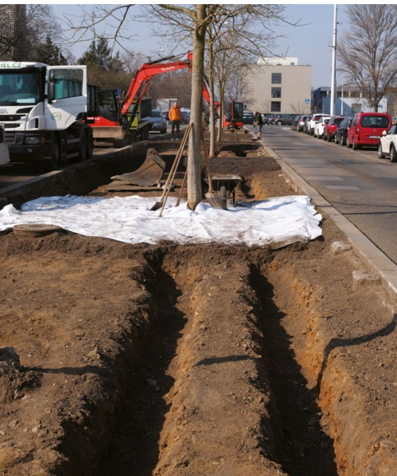
▲ Hloubení kořenových cest pod vegetačním souvrstvím záhonu
