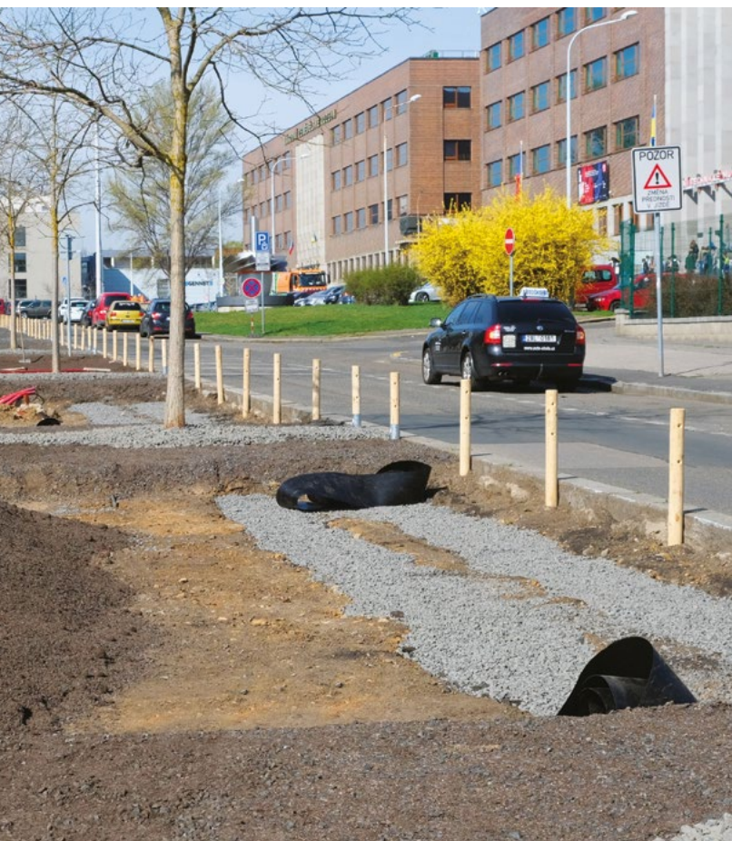
▲ Modelace prohlubní v segmentech mezi stromy a navážka štěrkového substrátu pro výsadbu trvalek
