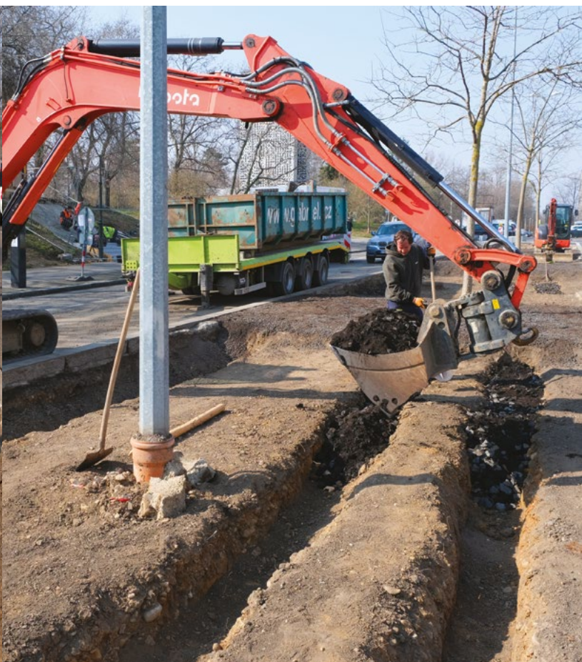
▲ Zavážení kořenových cest strukturálním substrátem
